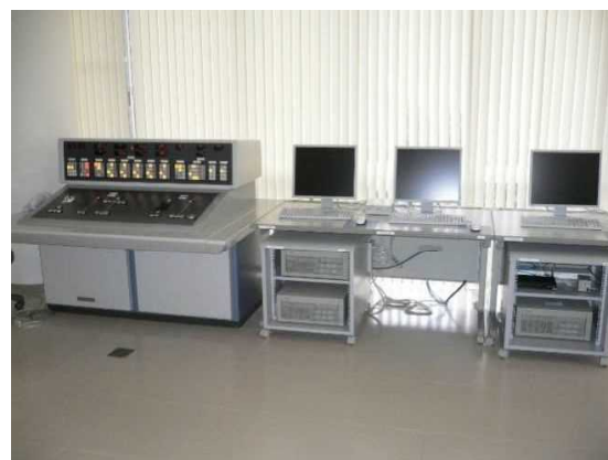
志河川ダム管理所
