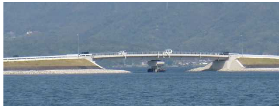
▲森山堤開削部
