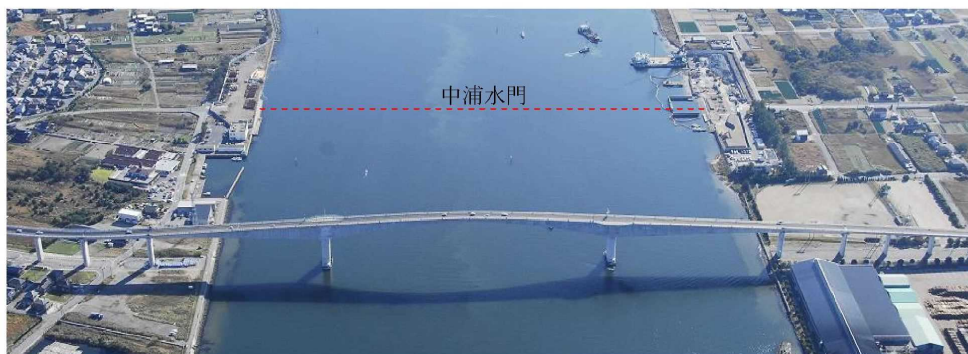
▲中浦水門撤去後(平成20年12月撮影)
