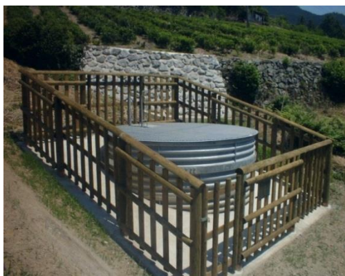
間伐材を用いた防護柵（桃原・西桃原区域）
