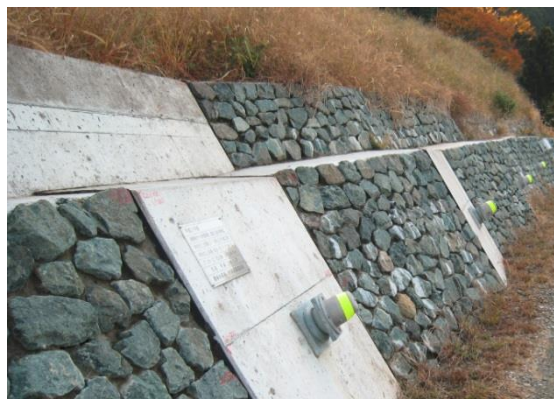
現場発生石材を用いたアンカー工（中村大王上区域）
