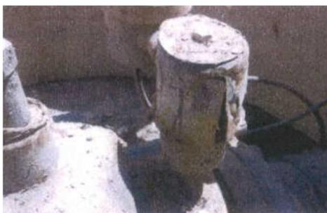
▲電磁弁ボンネット部の錆による散水不良が発生（彦名工区及び弓浜工区）
