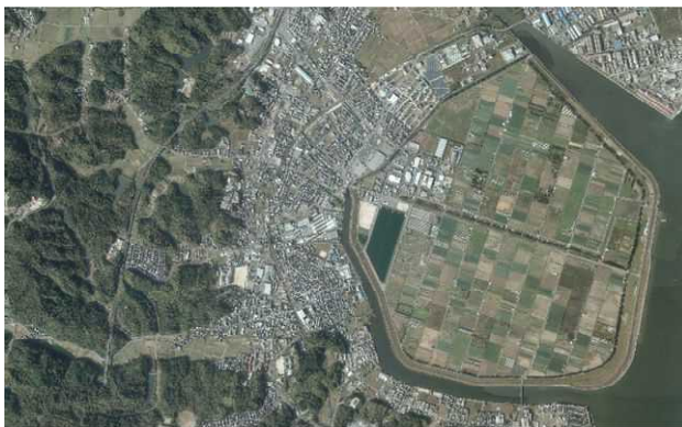
▲ い 揖屋工区(松江市)
