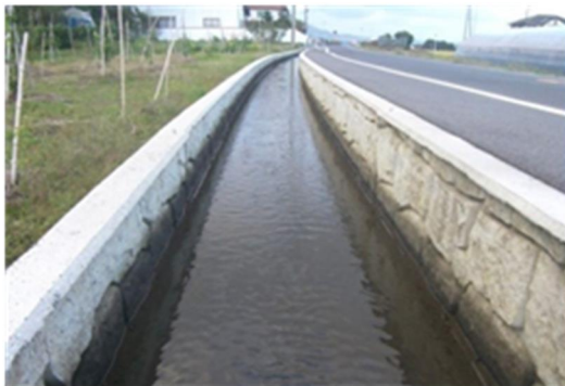
国富幹線用水路（改修）
