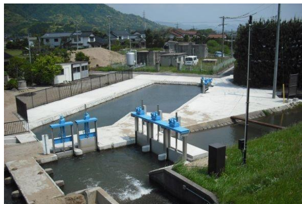
▲ 沈砂池（国富幹線用水路）
