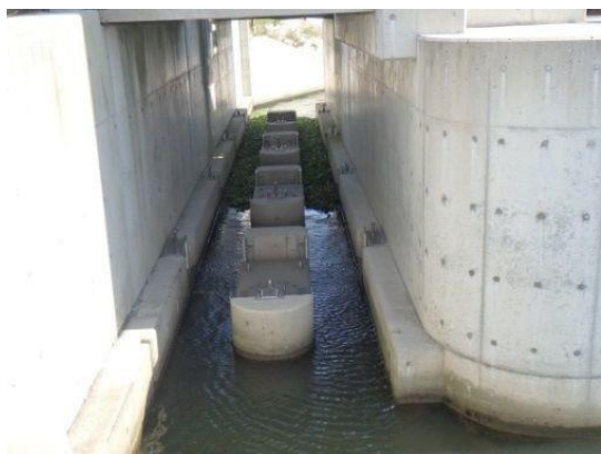
▲平田船川汐止堰の魚道（左岸：上流から）
