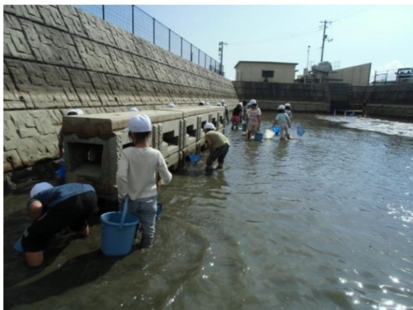
▲天神揚水機場の魚巣ブロック
