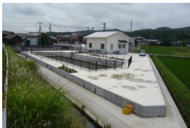
以南東部揚水機場
