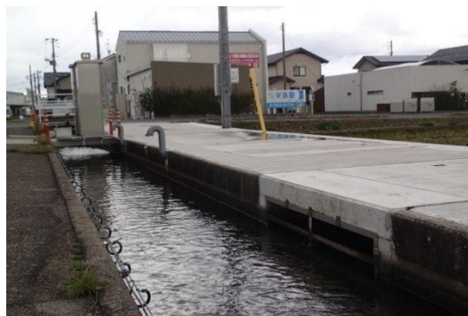
右岸高瀬川用水路注水口(新設)
