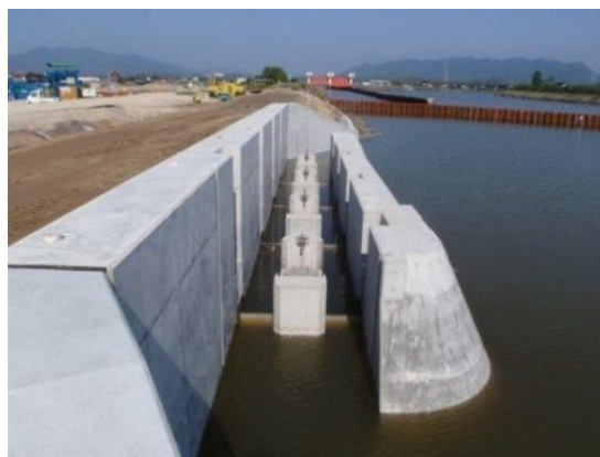
▲平田船川汐止堰の魚道（右岸：下流から）
