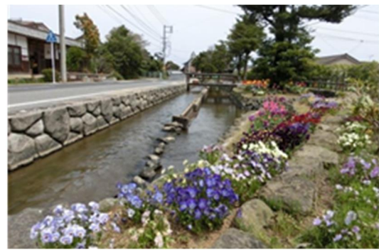
砂川用水路(改修)
