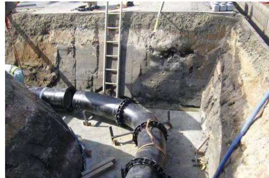
右岸導水路(新設)
