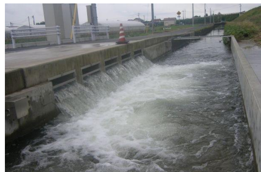
右岸幹線用水路注水口(新設)
