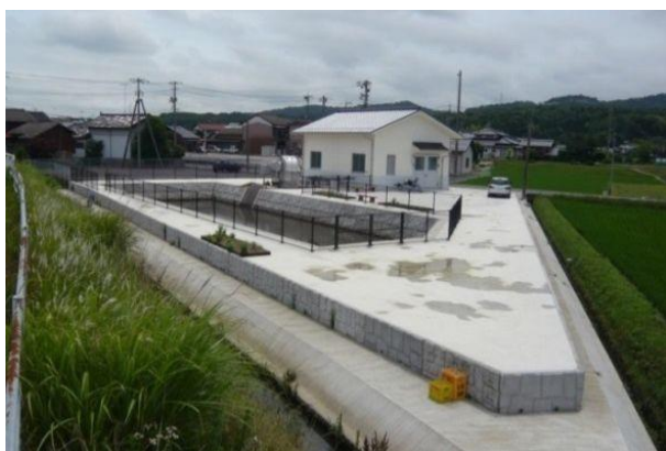
以南東部揚水機場
