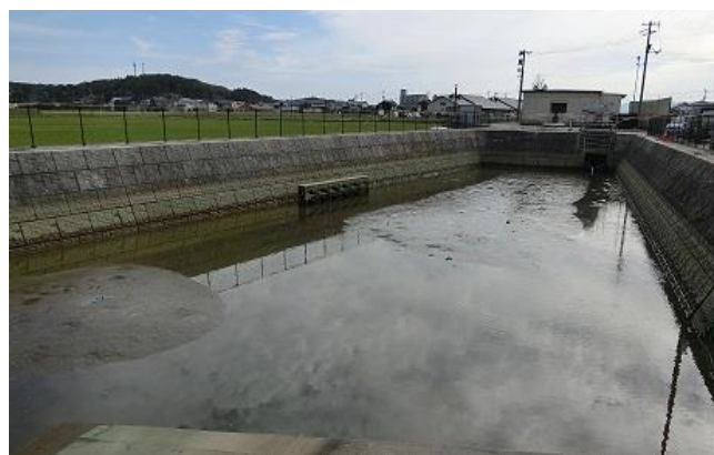
天神揚水機場
