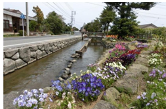
砂川用水路(改修)
