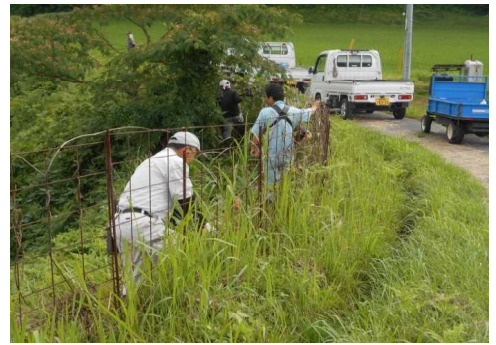
ワイヤーメッシュ設置作業
