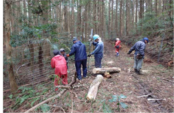
写真4 防護柵設置の様子
