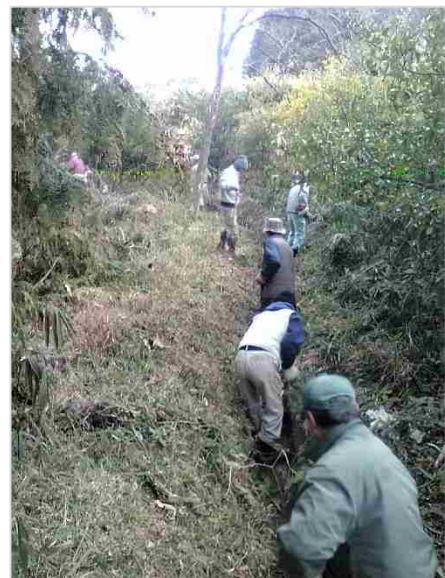
写真5 用水路の保全作業
