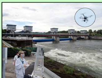
ドローンによる頭首工の調査
