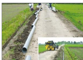
開水路の管路化
