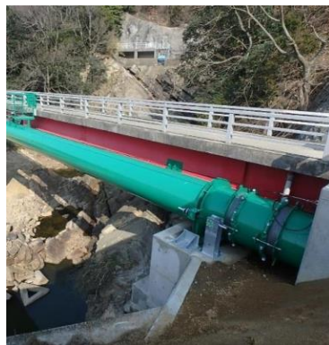
落橋防止対策
