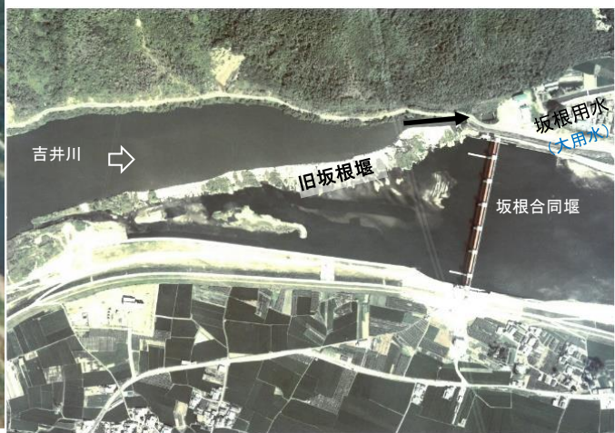
旧坂根堰と坂根合同堰（建設中）
