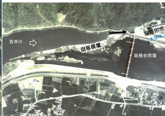
旧坂根堰と坂根合同堰（建設中）
