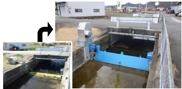
はしりあがりてんとうぜき 転倒ゲート整備（走上転倒堰）
