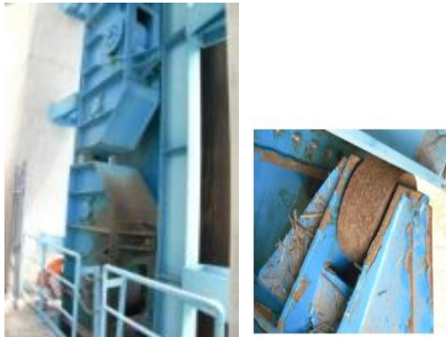
ゲートローラー部が腐食（新田原井堰）
