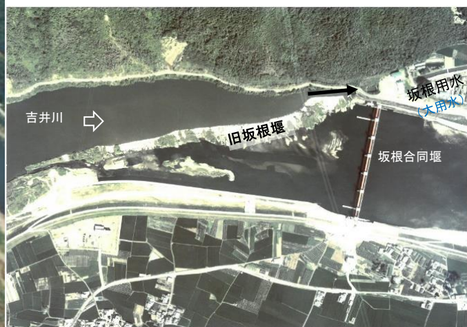
旧坂根堰と坂根合同堰（建設中）
