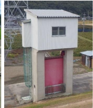
右岸制水ゲート
