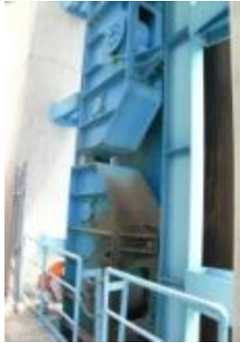
ゲートローラー部が腐食（新田原井堰）
