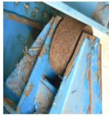
ゲートローラー部が腐食（新田原井堰）
