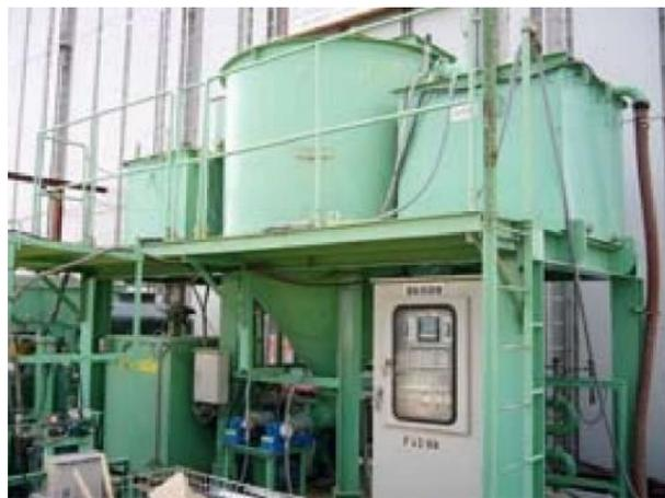
濁水流出防止施設（濁水処理施設）（イメージ）
