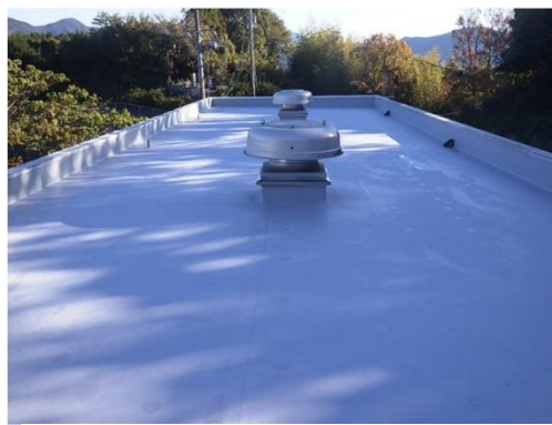
1号支線揚水機場 屋根防水（整備後）
