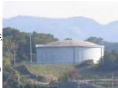
国営事業で整備された調整水槽
