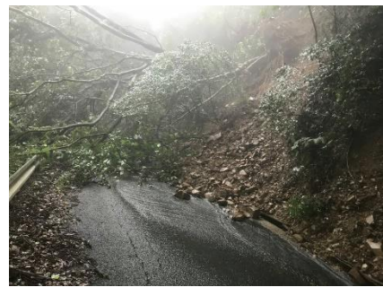
土砂崩れによる倒木でほ場へ続く道路 の封鎖(八代パイロット頂上線)
