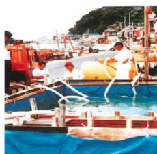
簡易水槽による給水作業
