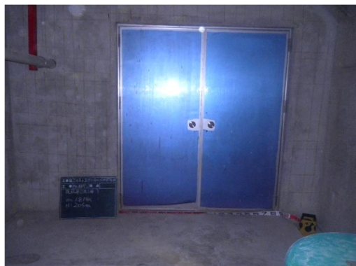
南予用水取水塔 防水扉（整備前）
