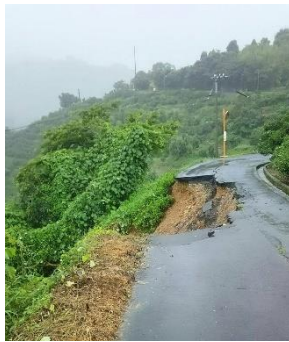
土砂崩れによる道路の 陥没
