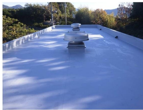
1号支線揚水機場 屋根防水（整備後）
