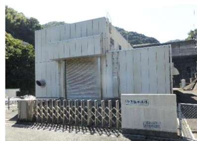
伊方揚水機場
