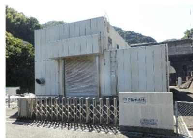
伊方揚水機場
