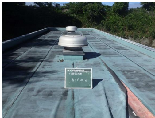
1号支線揚水機場 屋根防水（整備前）
