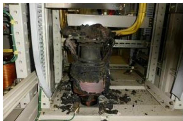
スイッチの誤作動（電動機始動器の焼損事故(伊方２号支線揚水機場)）
