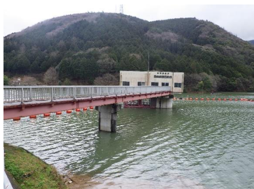
南予用水取水塔（全景）
