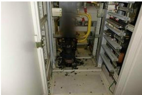
スイッチの誤作動（電動機始動器の焼損事故(伊方２号支線揚水機場)）
