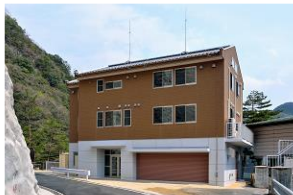
ダム管理事務所建屋
