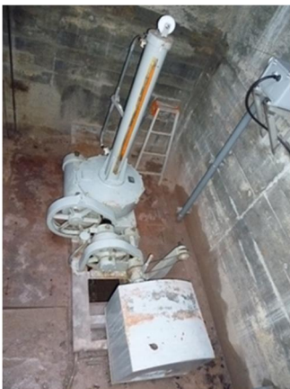
放流ゲート室内 (更新前)
