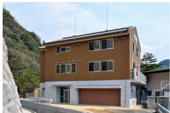
ダム管理事務所建屋
