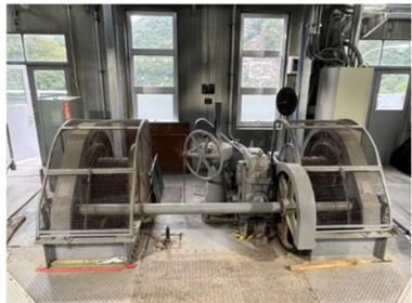
腐食によりローラーの回転不良が生じており、戸当りと摩擦抵抗が増加して、大きな開閉力が必要となっている。
