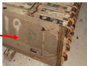
パネルのサイドローラ腐食
