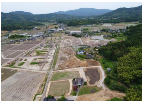
伊陸中央第3団地（区画整備中） R5年5月
