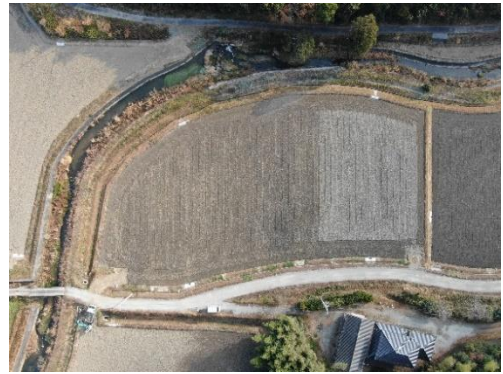
宮ヶ原・中村団地（暗渠排水施工後）
