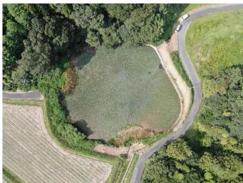
妙法寺池（工事着手前）R2年8月
