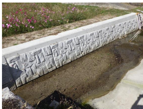
景観に配慮した護岸ブロック (中郷団地)
