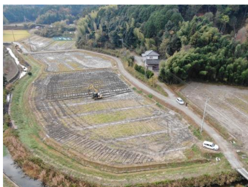
補助孔の施工 R2年11月
