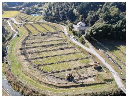
幹線・支線パイプの施工 R2年11月
