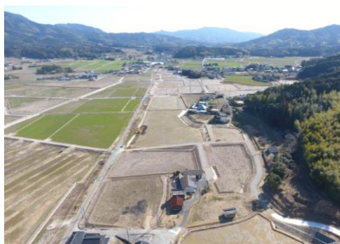
伊陸中央第3団地（区画整備後） R6年2月
