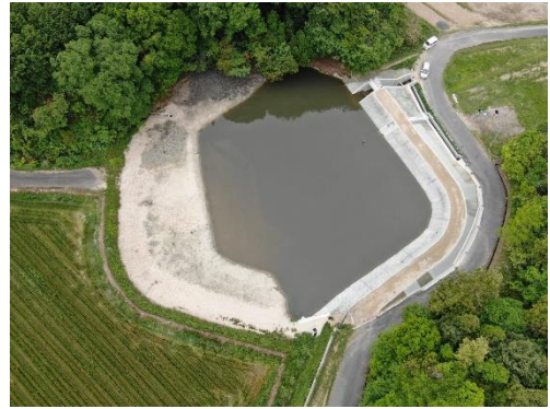
妙法寺池（ため池整備後）
