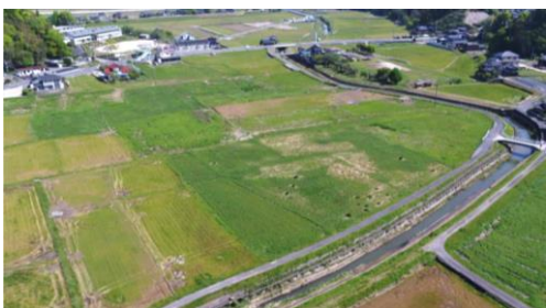
西田布施・友石団地（区画整備前） R5年4月
