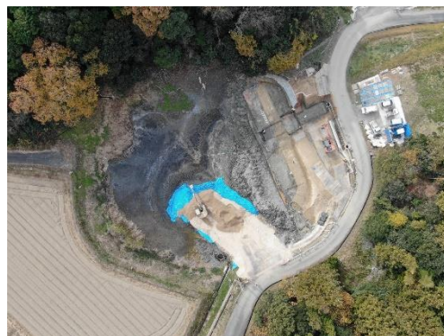
妙法寺池（工事中）R2年12月
