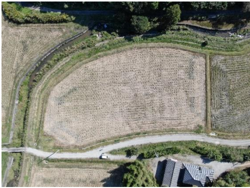
宮ヶ原・中村団地（暗渠排水施工前）
