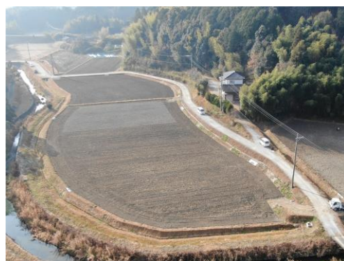
工事後 R2年12月
