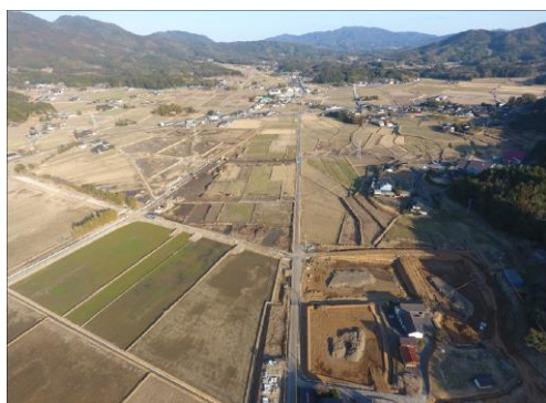
伊陸中央第3団地（区画整備中） R5年1月
