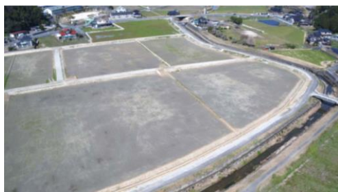
西田布施・友石団地（区画整備後） R6年3月
