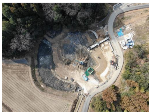
妙法寺池（工事中）R3年1月
