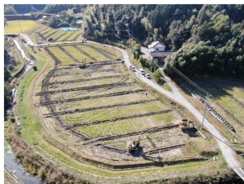
幹線・支線パイプの施工 R2年11月
