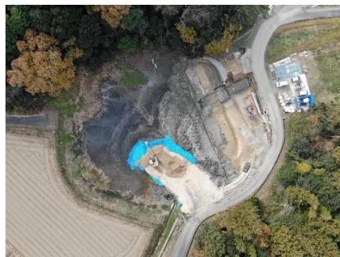
妙法寺池（工事中）R2年12月
