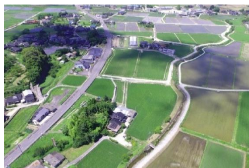
伊陸中央第3団地（区画整備後）
