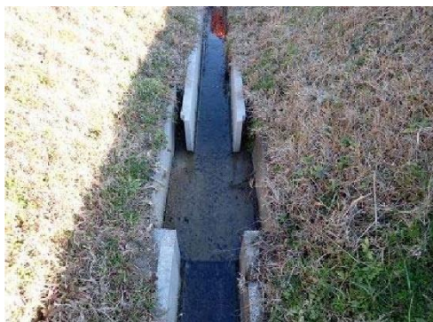
宿井団地における縦型スロープ水路（左：設置直後、右：モニタリング調査時）
