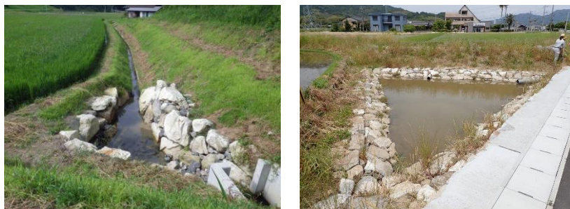
現地発生材を利用して造られた環境配慮施設
