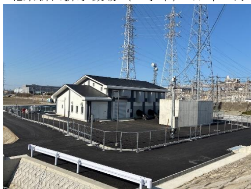
北条新田排水機場（工事後）R8年3月
