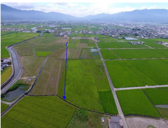
北条・北条新田工区 2号幹線排水路（農業用排水施設整備前）
