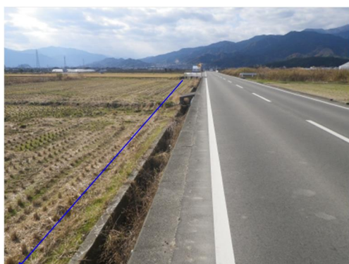
徳出・安出・明理川工区 1号幹線排水路（工事着手前）H29年12月
