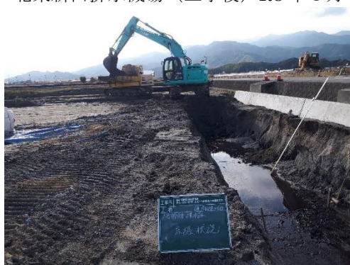
徳出・安出・明理川工区 1号幹線排水路（工事中）R2年11月
