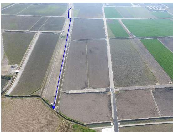
北条・北条新田工区 2号幹線排水路（農業用排水施設整備後）
