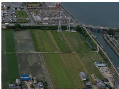
北条新田排水機場（工事着手前）R2年6月
