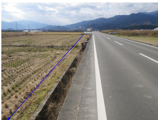
徳出・安出・明理川工区 1号幹線排水路（農業用排水施設整備前）
