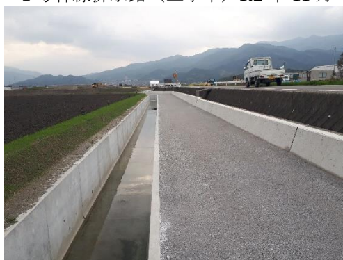
徳出・安出・明理川工区 1号幹線排水路（工事後）R3年3月
