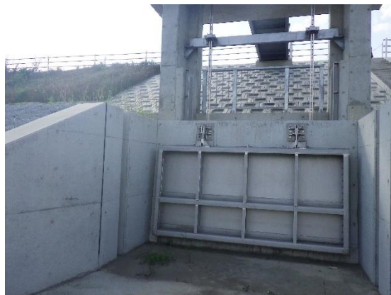
田野上方東・周布工区 中山川排水樋門（農業用排水施設整備後）
