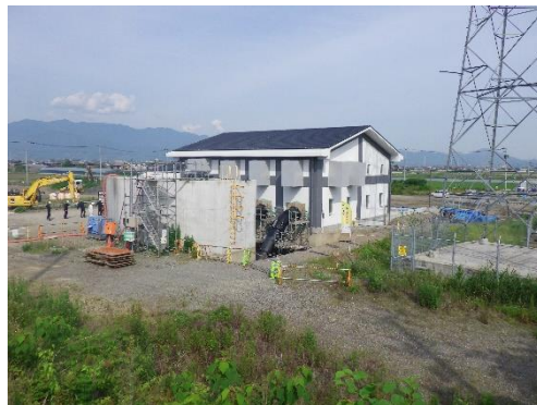
北条新田排水機場（工事中）R7年5月
