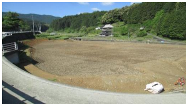
基盤整備後の様子
