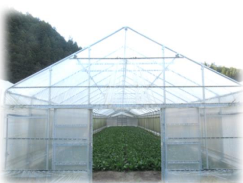
遮光などを工夫した単管パイプハウス
