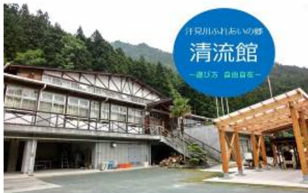
平成20年5月から旧小学校を宿泊施設として運営
