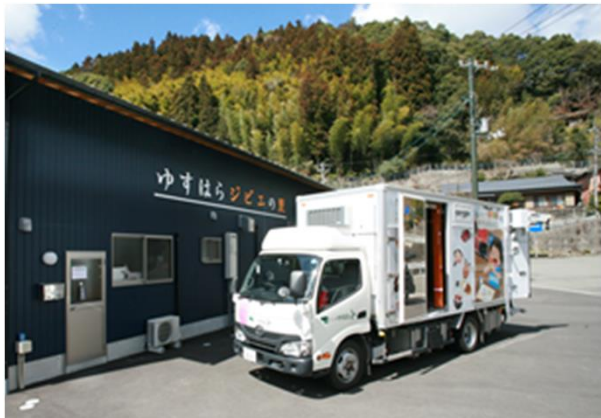
獣肉解体処理施設とジビエカー
