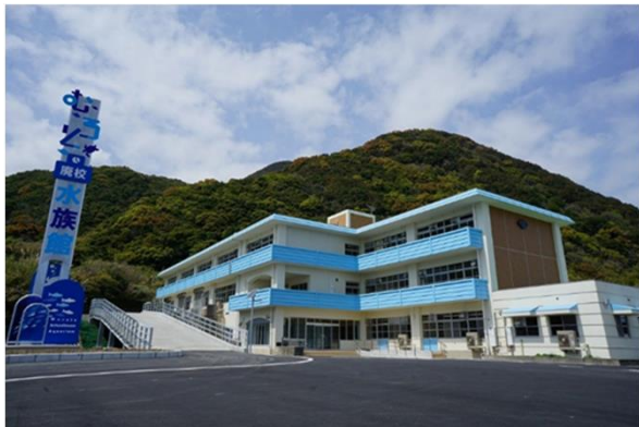
廃校となった校舎をそのまま利用
