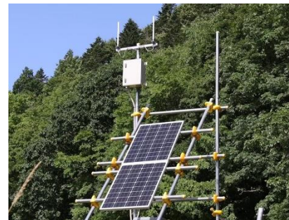
LPWA (LoRaWAN®) 基地局
