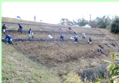
ため池法面の小段設置
