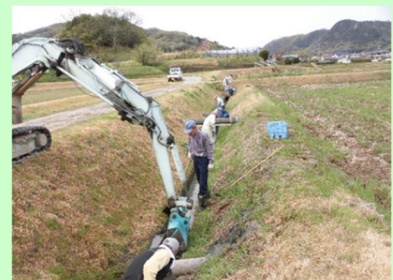
重機を使った水路の泥上げ
