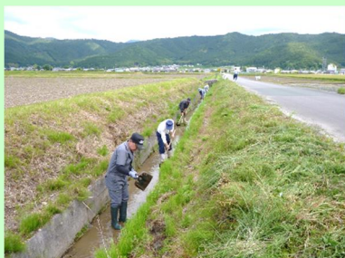
水路の泥上げ
