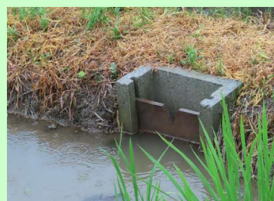
たんぼダムの取組 （V字カットの堰板）
