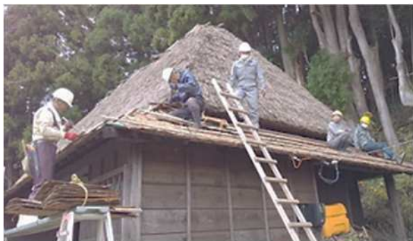
茅葺(かやぶき)屋根の杉皮の張替え
