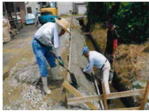
用排水路の修繕工事 地元構成員の直営施工
