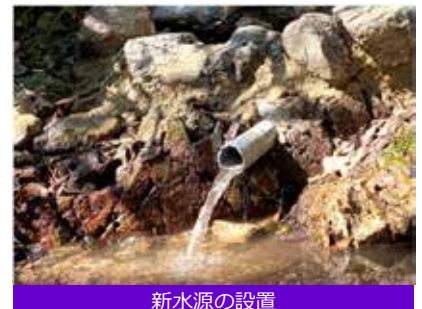
新水源の設置
