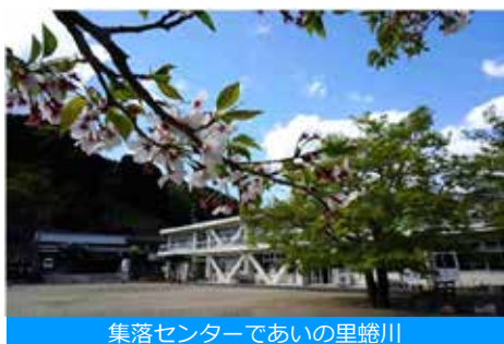
集落センターであいの里蜷川
