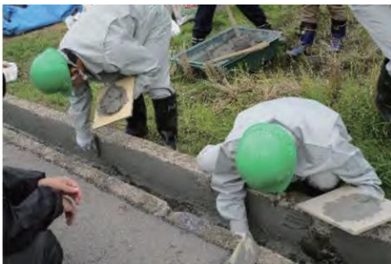
高校生との水路補修 側壁の補修
