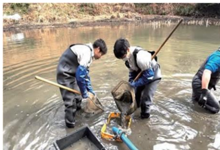
サイフォンによる浚渫の様子
