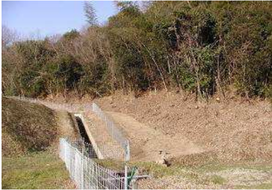
侵入防止柵設置で野生獣を寄せ付けない
