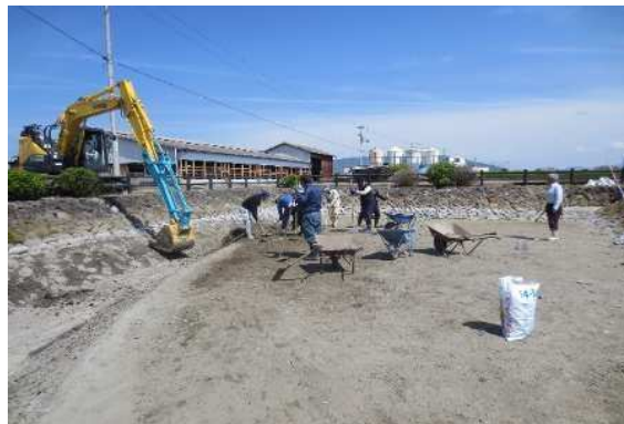
遊水池の清掃・泥上げ
