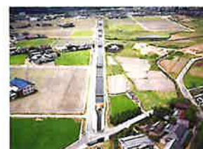
香川用水幹線水路・開水路区間
